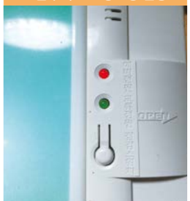
예비전원(배터리) 전압부족으로 경고등 점등
