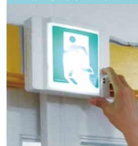
점검버튼을 이용한 유도등 예비전원 확인
